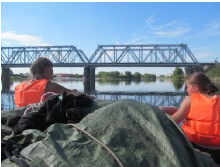
Фото 35. Железнодорожный мост г. Канск.
